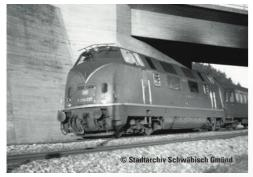
**Vorbild**: Schwere dieselhydraulische Lokomotive V 200 037 der Deutschen Bundesbahn (DB). Mehrzwecklokomotive V 200.0 in purpurroter Farbgebung im Betriebszustand Anfang der 1960er-Jahre.
