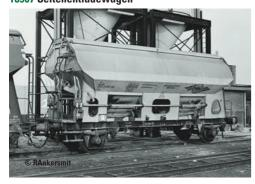
Vorbild: Rundschieber-Seitenentladewagen Tds der Firma ARMITA WAGONS, eingestellt bei den Niederländischen Staatseisenbahnen (NS). Ausführung mit Schwenkdach über dem Laderaum.
